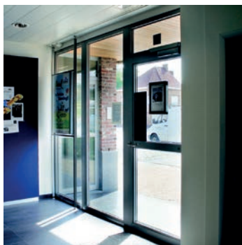
Figuur 36: entree bij appartementengebouw
