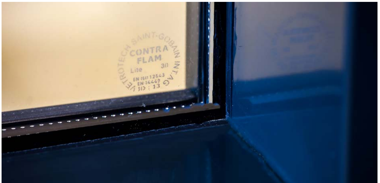
Figuur 26: N.B. de hoek waarin de stempel in het brandwerend glas is gemarkeerd, dient aan de onderzijde te worden gemonteerd
