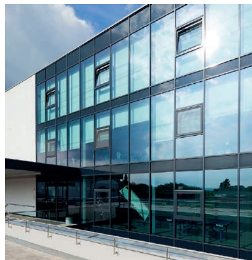
Figuur 38: Voorbeeld van een vliesgevel
