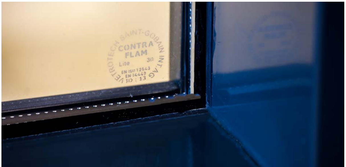
Figuur 21: N.B. de hoek waarin de stempel in het brandwerend glas is gemarkeerd, dient aan de onderzijde te worden gemonteerd
